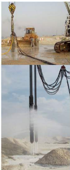
振冲器—地基加固+碎石桩
